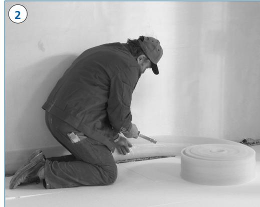
2 Der Randdämmstreifen für Zement- und Fließestriche ist umlaufend im oberen Drittel an der Wand zu fixieren.
