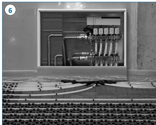
6 Nach der Verlegung der Heizrohre wird vor dem Estrichschutzblech des Verteilerschranks der Randdämmstreifen befestigt.
