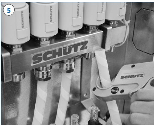
5 Am Heizkreisverteiler wird der Rücklauf passend abgelängt. Adapter-Klemmverbinder bestehend aus Überwurfmutter, Klemmring und Stützhülse sorgen für eine sichere Verbindung von Heizrohr und Verteiler.
