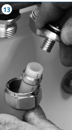
Überwurfmutter, Klemmring und Stützhülse sorgen für eine sichere Verbindung von Heizrohr und Verteiler.
