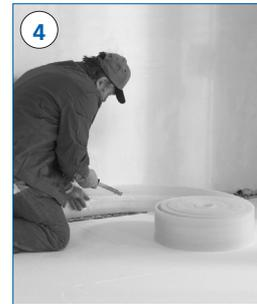
4 Der Randdämmstreifen wird umlaufend im oberen Drittel an der Wand fixiert.
