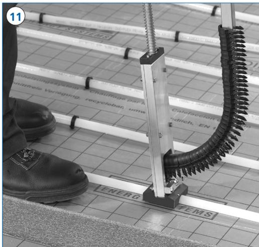
Mit Hilfe des Montagegerätes „Erwin“ werden die Heizrohrhalter im Abstand von maximal 50 cm zur Fixierung des Rohres in die Systemplatte gedrückt.
