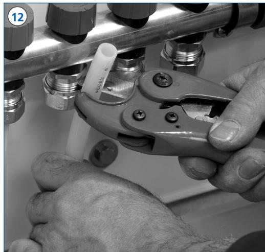
Am Heizkreisverteiler wird der Rücklauf passend abgelängt.
