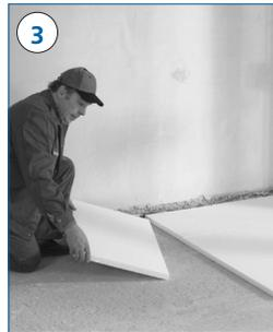
3 Gegebenenfalls wird zunächst eine Lage Zusatzdämmung ausgelegt.
