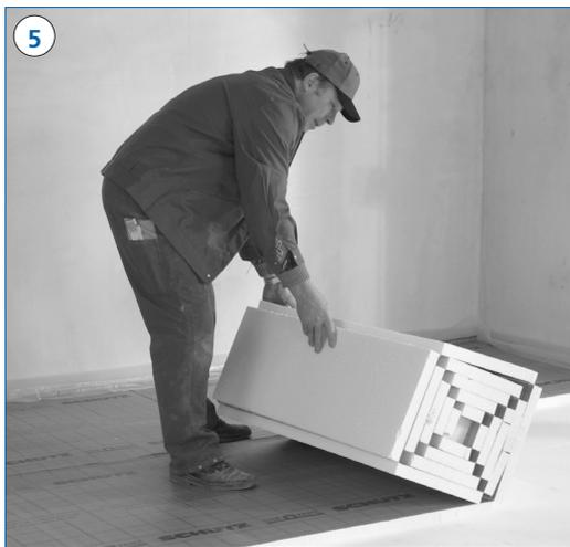
5 Klappen bei kleinen Räumen, Rollen bei großen Flächen: die quadro-takk PRO Faltrolle ist einfach und schnell zu verlegen.
