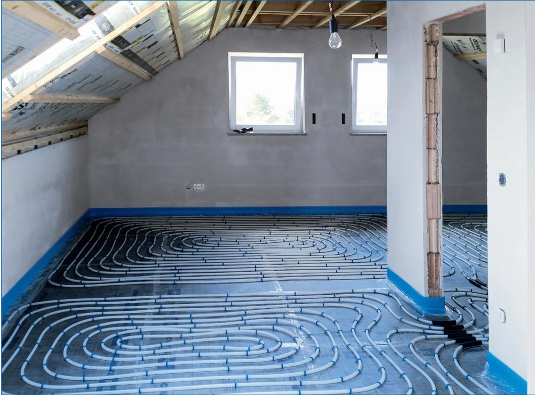
Dabei dient die Systemplatte nicht nur zur Heizrohrbefestigung, sie trägt gleichzeitig zur Wärmedämmung und Trittschallverbesserung bei.
