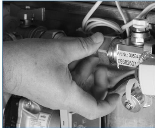
Der Pumpenblock ist sekundärseitig einfach und schnell, unter Verwendung der beiliegenden Dichtungen, mit dem Heizkreisverteiler Typ Komfort 90-3 zu verschrauben.
