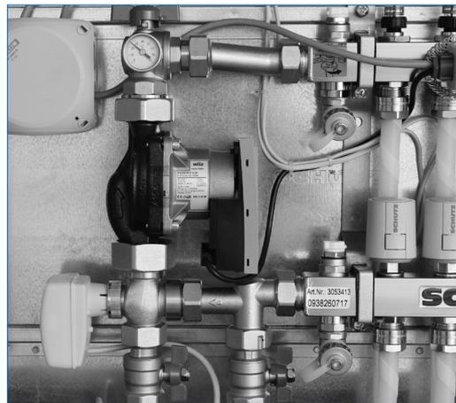
Für **varimat WR**: Anstatt des Festwertreglers wird der Dreipunktmotor Kleinventilantrieb am 3-Wege-Ventil aufgeschraubt. Dabei ist der Anlegefühler am oberen Vorlaufbalken zu montieren.
