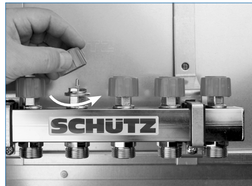
Vor- und Rücklaufventil des ersten Heizkreises öffnen. Hauswassernetz mit Leitungsdruck durchspülen.
