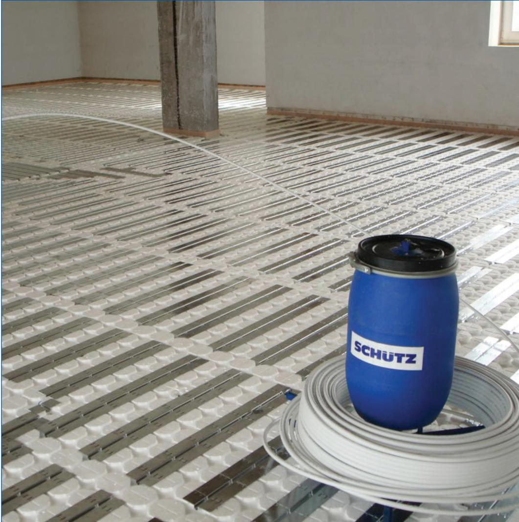
En los sistemas de construcción seca los tubos se colocan en módulos difusores de calor que encajan en los paneles de aislamiento. Los módulos difusores de calor aseguran una difusión uniforme del calor.
