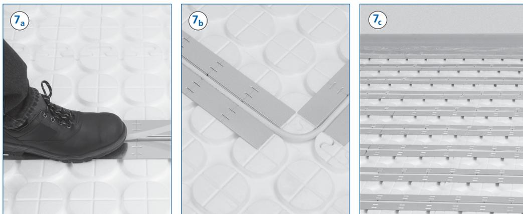
Empezando por el colector, presione con cuidado el tubo en las chapas difusoras de calor con el pie. En la zona de desviación, el tubo es guiado en curva alrededor de las levas de desviación. En este caso, el radio de curvatura mínimo viene dado por la geometría del panel. Si se necesitan canales de tubo o desviaciones adicionales, pueden hacerse simplemente a mano con un cuchillo afilado.
