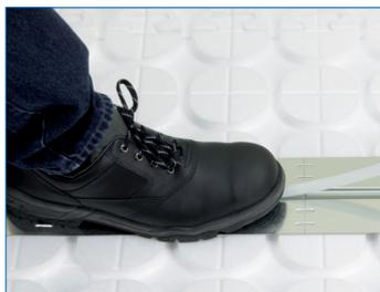
El tubo se presiona simplemente con el pie en los módulos difusores de calor.
