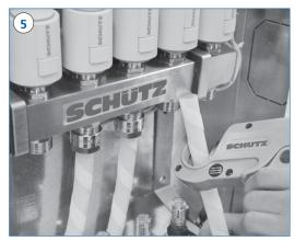
El tubo de retorno se corta a medida en el colector. Los racores de unión tubo-colector que constan de tuerca loca, anillo opresor y casquillo de soporte garantizan una unión segura de tubo y colector.
