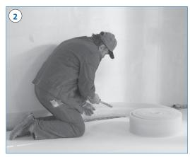
La cinta perimetral para morteros de cemento y morteros autonivelantes debe fijarse en la pared en el tercio superior.
