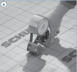
Las juntas de tope se sellan contra la penetración del mortero mediante cinta adhesiva y una máquina de precintar.
