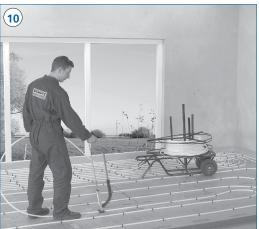
Si se utilizan morteros autonivelantes, el faldón de la cinta perimetral La instalación comienza en la zona de las ventanas con un paso menor (zona marginal).
