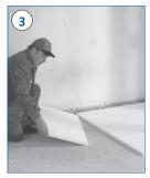
Si es necesario, se coloca primero La cinta perimetral se coloca en la una capa de aislamiento adicional.
