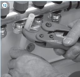
Se corta el tubo de retorno a medida para ser posteriormente fijado en el colector.
