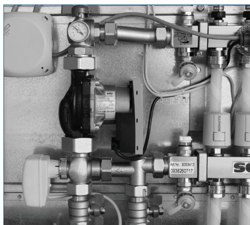
**Para varimat WR:** En lugar del termostato de valor fijo, se atornilla el servomotor de tres puntos en la válvula de 3 vías. El sensor de contacto debe montarse en la barra de impulsión superior.
