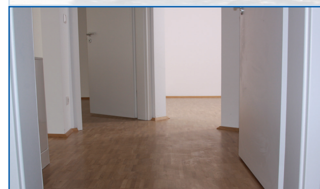
Dank 50 mm Aufbauhöhe blieb die Raumhöhe unverändert.
